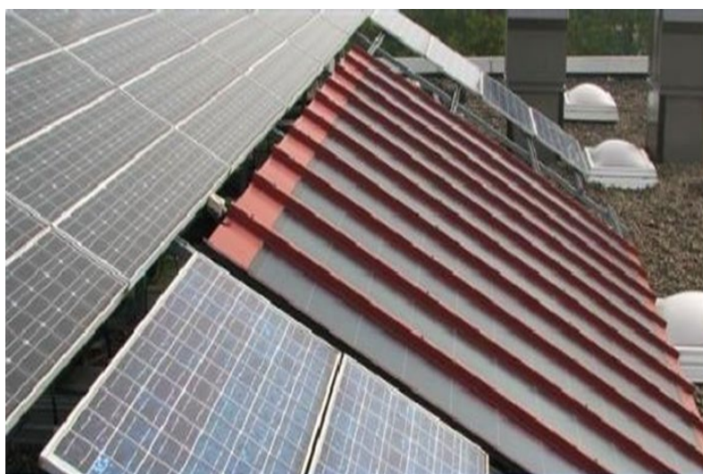
1.5 – сурет - Жылу алмастырғышы бар аралас күн электрстанциясы
