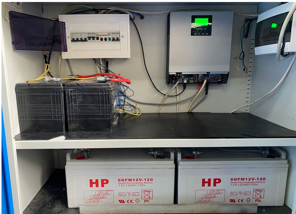
3.5 – сурет – Expert MEX-3000-24 инвертор және қосу схемасы
